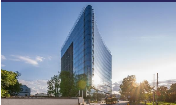
Wrocław, ul. Fabryczna
