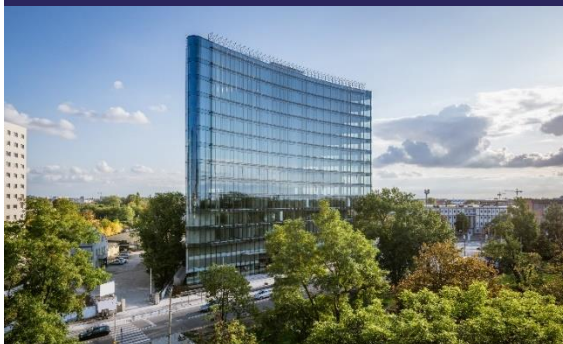
Wrocław, ul. Fabryczna
