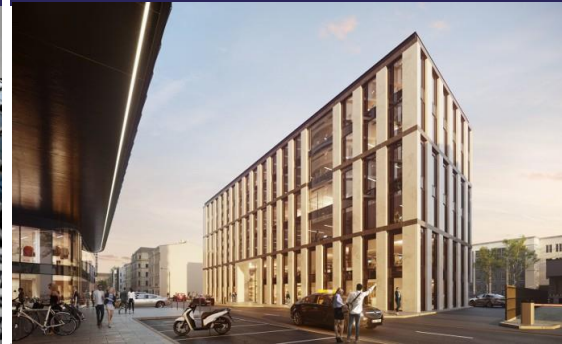
Katowice, ul. Mickiewicza
