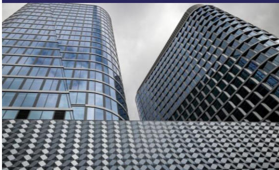
Katowice, ul. Mickiewicza
