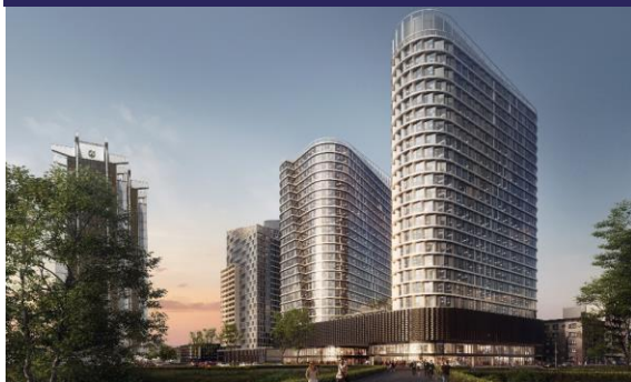
Katowice, ul. Mickiewicza
