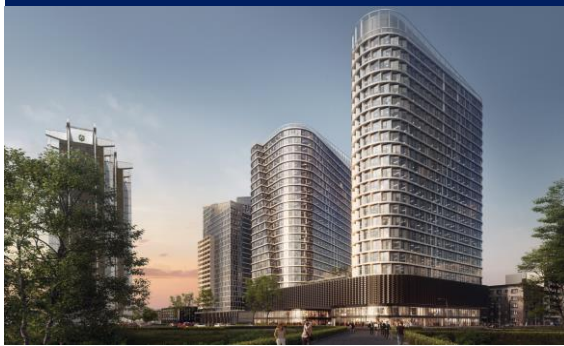
Katowice, ul. Mickiewicza
